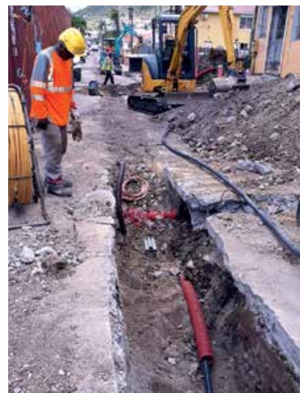
Enfouissement souterrain des réseaux
