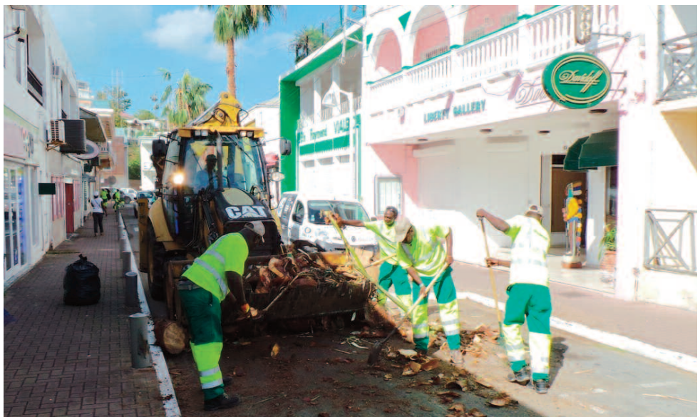
Les personnels de nettoyage à l'ouvrage après le passage de l'ouragan
