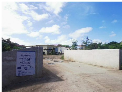
Figure 14 : Ouvrage de protection contre les inondations – Ravine Paradis (Mayane 2023)
