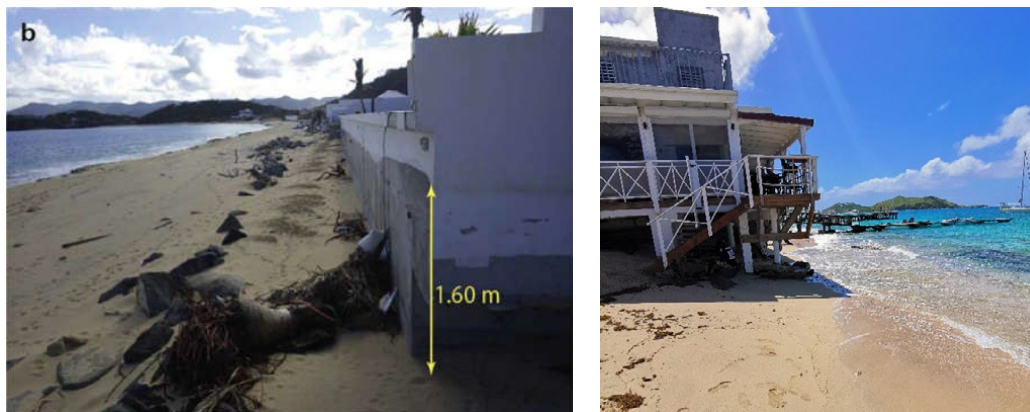
Figure 7 : Érosion de la Baie Rouge (Duvat et Volta, 2017) (à gauche), érosion de la plage de Grand Case (Mayane, 2023)
