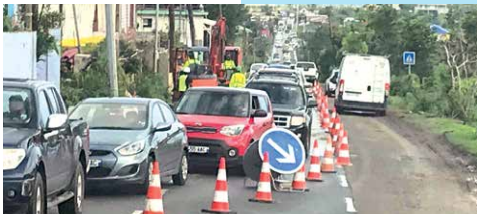
Une troisième voie temporaire sur la route de La Savane
