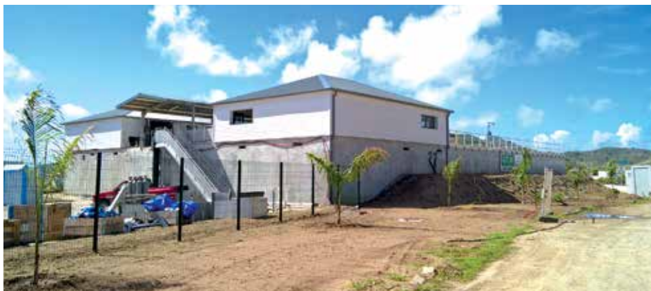
Vue générale de la station d'épuration de Quartier d'Orléans
