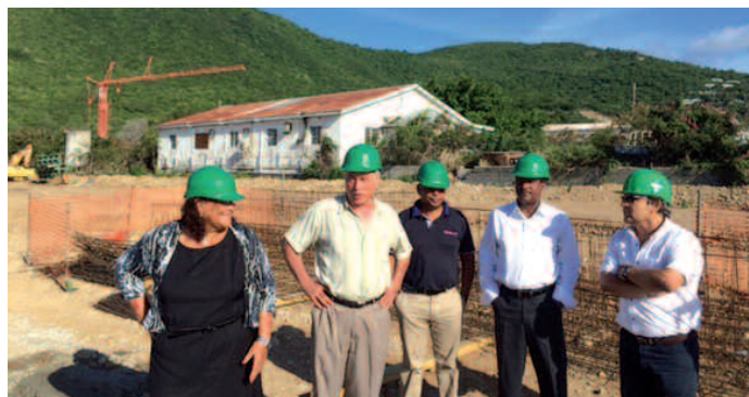
Le comité de pilotage en visite de chantier
